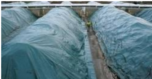
Ilustración 6: Sistema de pilas estáticas aireadas
