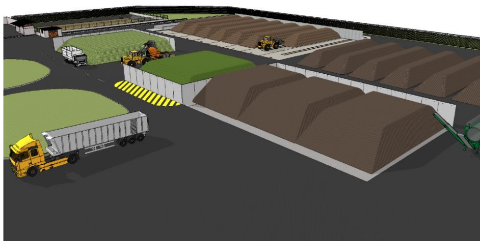
Ilustración 15: Planta de compostaje con proceso por pilas (Veolia)
